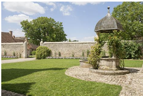
5. Le château de Talcy © Jean-Pierre Delagarde – Centre des monuments nationaux
