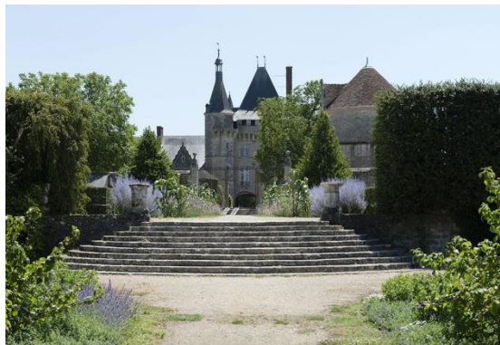
Vue côté jardins du château de Talcy © Colombe Clier – Centre des monuments nationaux
