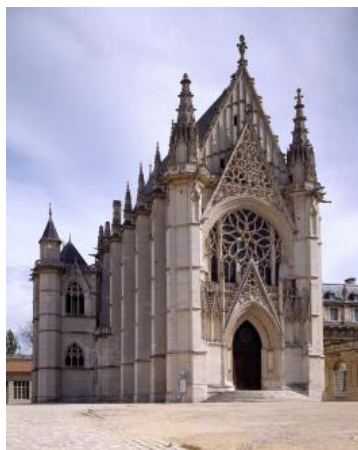
La façade occidentale de la Sainte-Chapelle du château de Vincennes © Patrick Müller - CMN
