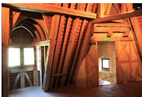
Château de Fougères-sur-Bièvre, les combles © Gilles Codina - CMN
