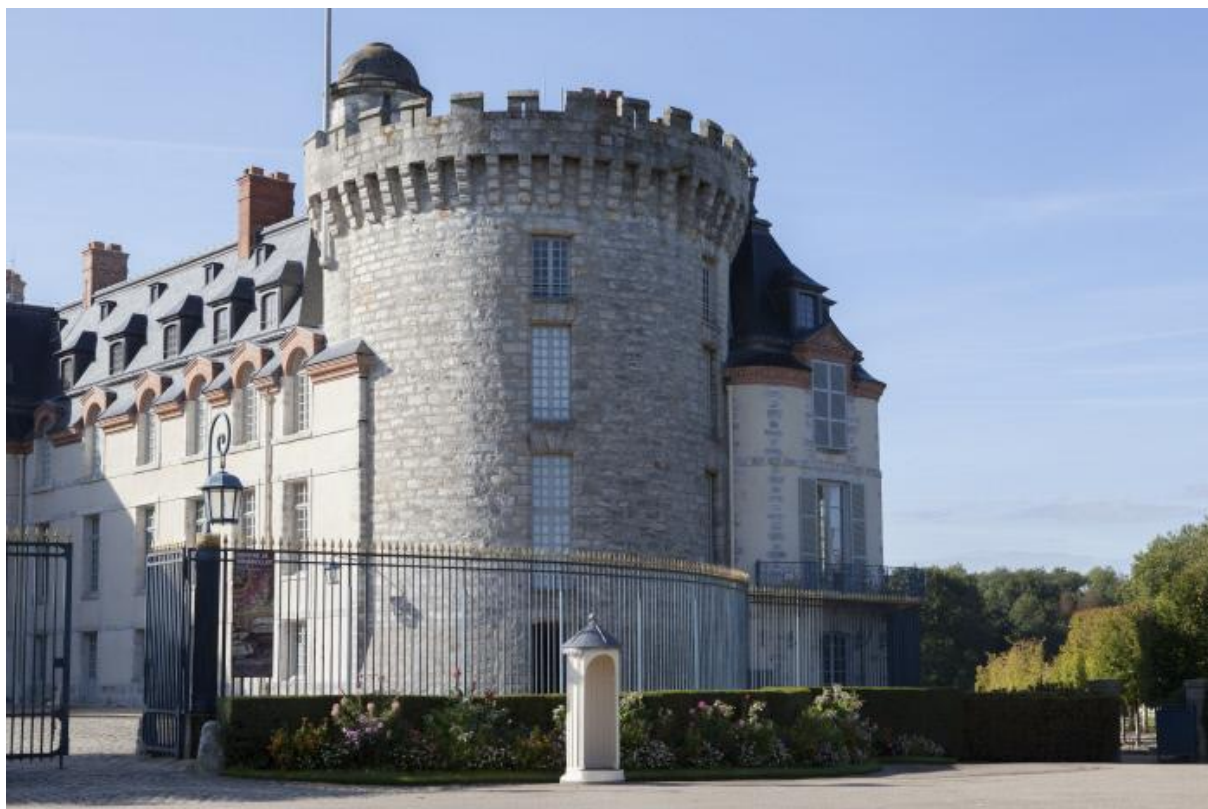
Château de Rambouillet – Tour dite « François I er » © Laurent Gueneau - CMN
